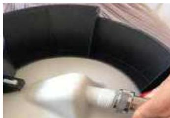
**3** | Avvitare la doccetta al flessibile in dotazione con l'apposita guarnizione.
